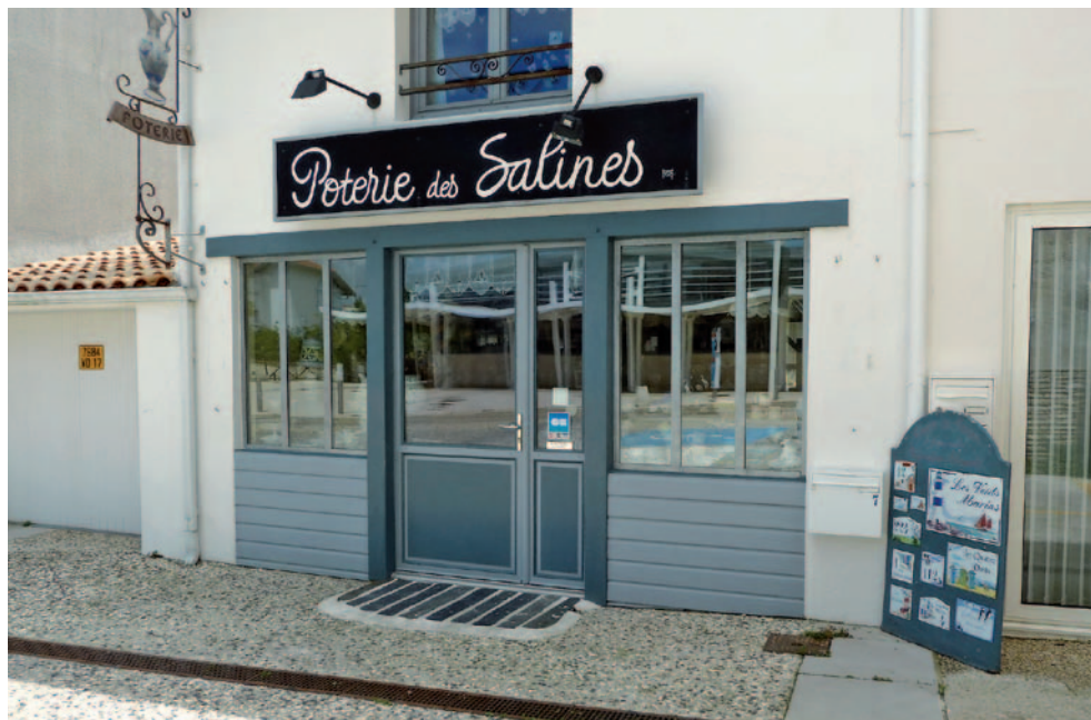
■ Installation d'une vitrine dans l'encadrement d'un ancien garage.
