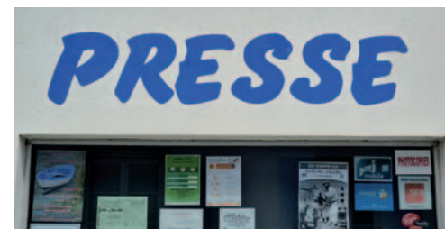
■ Enseigne peinte directement sur la maçonnerie
