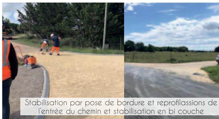
Stabilisation par pose de bordure et reprofilations de l'entrée du chemin et stabilisation en bi couche
