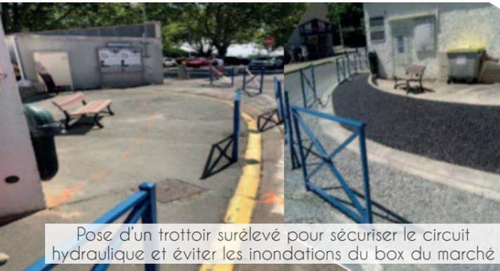
Pose d'un trottoir surélevé pour sécuriser le circuit hydraulique et éviter les inondations du box du marché
