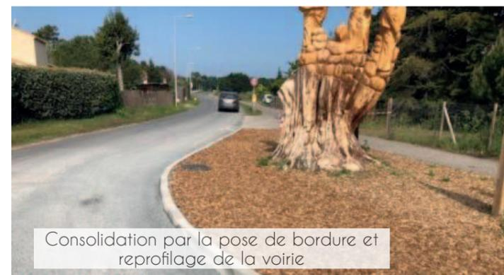
Consolidation par la pose de bordure et reprofilage de la voirie
