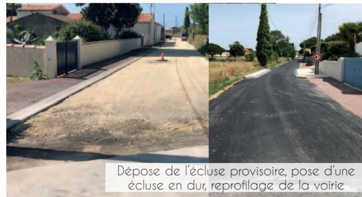
Dépose de l'écluse provisoire, pose d'une écluse en dur, reprofilage de la voirie
