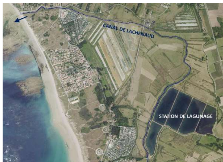
Station de lagunage de Saint-Denis-d'Oléron
