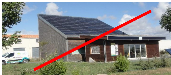
La pente de cette toiture solaire est trop prononcée
